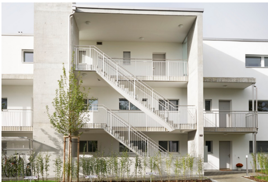
Abbildung 5 Gerade Treppe als interne Gebäudeerschliessung beim Laubengang
