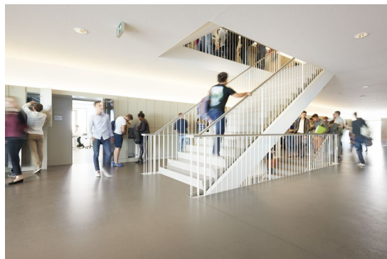
Abbildung 2 Treppen müssen in einwandfreiem Zustand gehalten werden
